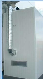
*Schallschutzeinhausung für eine Absaug- und Filteranlage*
