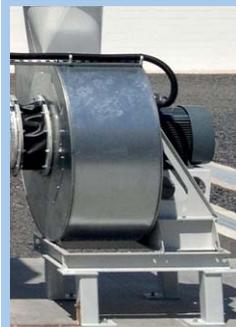
*Mittelvakuum-Ventilator mit Gehäuseschallisolierung*
