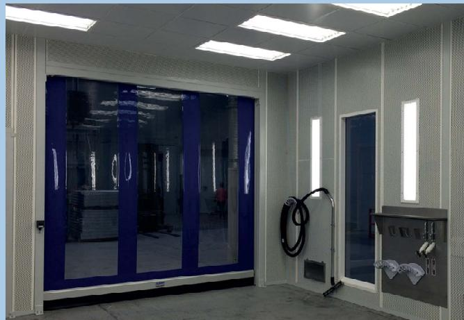
*Schallschutzkabine für Schleifarbeiten mit Absaug- und Filteranlage sowie Wärmerückgewinnungsanlage.*
