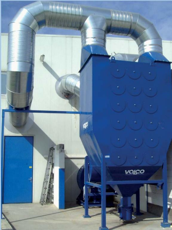
X-45-J mit 45 kW-Ventilator, 40.000 m³/h
