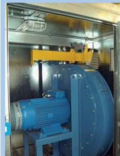
*Hochvakuum-Ventilator mit in einer Schallschutzeinhausung*
