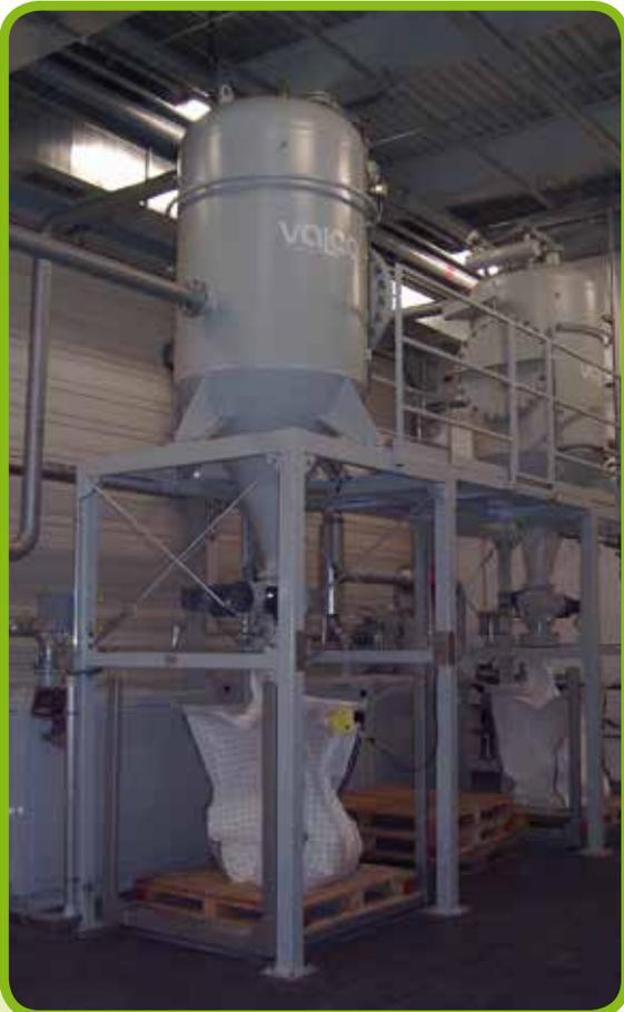
◀ BMW Regensburg - Zentrale Hochvakuumabsaug- und Filteranlage, exgeschützt, 11 bar druckstoßfest, 2 x 1500 m<sup>3</sup>/h, 35 kPa Unterdruck, je 30 kW Antriebsleistung, zum Absaugen von Pulverlackstäuben, die beim Lackieren nicht zurück gewonnen werden. Zusätzlich wird die Anlage zum Reinigen der gesamten Lackierstraße genutzt. Das Rohrsystem hat eine gesamte Länge von ca. 300 m.
