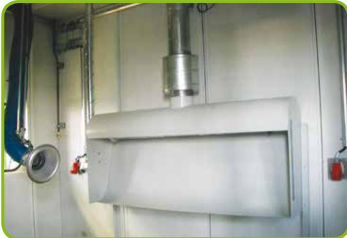
▲ Wirbelwind-Absaughauben aus Stahlblech mit gerader und gekrümmter Rückwand. Das speziell entwickelte Drallrohr im Inneren der Haube sorgt für eine gleichmäßige Erfassung über die gesamte Fläche. Mit geringen Volumenströmen wird ein hervorragendes Absaugergebnis erreicht.
