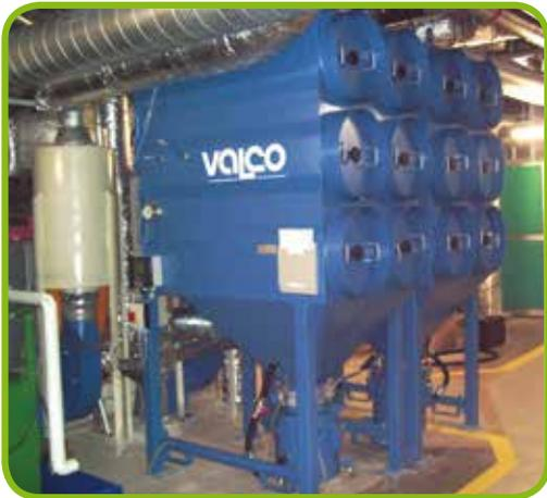
Patronenfilter mit 60 m<sup>2</sup> Filterfläche (PTFE-Membrane) und 60 m<sup>2</sup> Sicherheitsnachfilter, Filteranlage innerhalb für ATEX Zone 20
