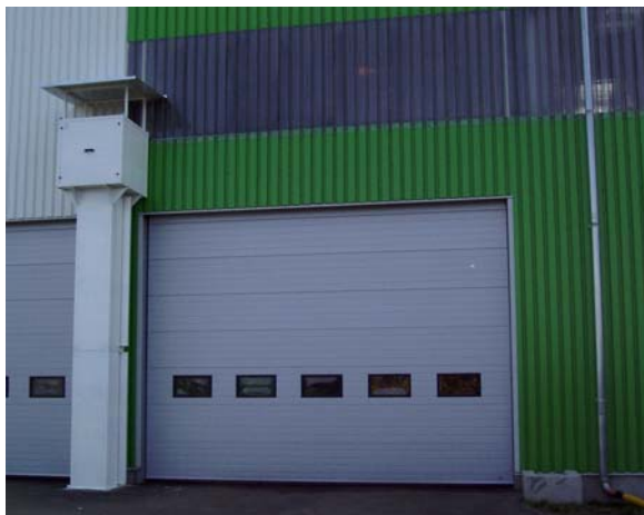
Luftsperranlage für Abfallrecyclingbetrieb, Torbreite 6 m, Torhöhe 5 m, Ventilator mit 18,5 kW Antriebsleistung. Ventilator ist mit der Torsteuerung verknüpft.
