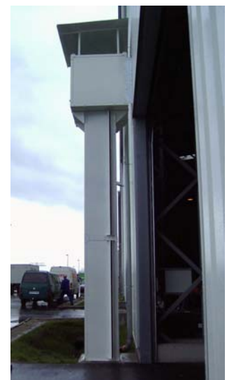
Luftsperranlage für Abfallrecyclingbetrieb, Torbreite 6 m, Torhöhe 5 m, Ventilator mit 18,5 kW Antriebsleistung. Ventilator ist mit der Torsteuerung verknüpft.
